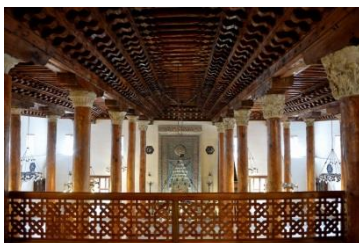
Асланхане Джамии. Анкара. 1289–1290 гг. Мечеть с деревянными столбами. Архитектор: Ебубекир Мехмет
